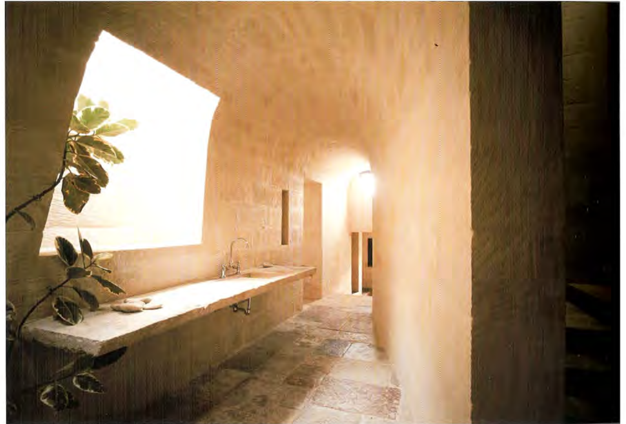
Particolare dell'intersezione tra la volta e il lucernario ipogeo Detail of the intersection between the hypogean vault and skylight
