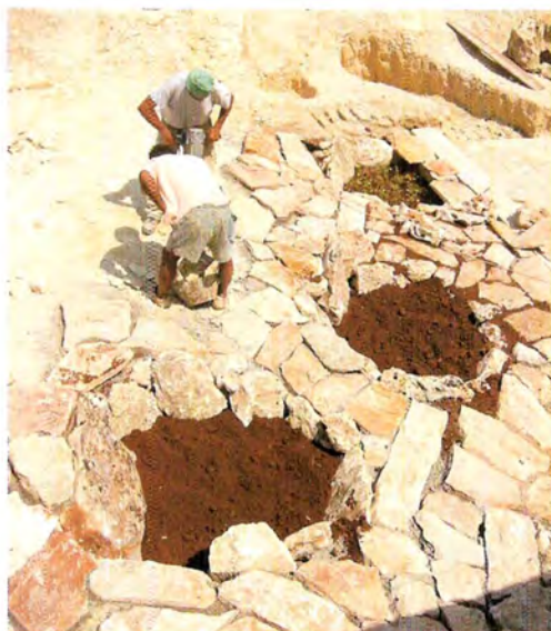
Dettaglio delle lavorazioni esterne in costruzione Underconstruction detail of external works
